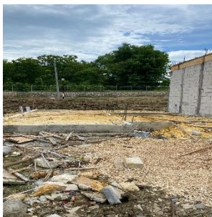
Gambar 1. Kondisi Agunan Rumah pada Progres Pembangunan \pm 50\%
