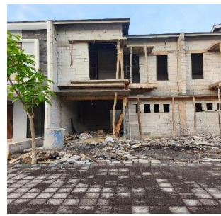
Gambar 2. Kondisi Agunan Rumah pada Progres Pembangunan \pm 70\%
